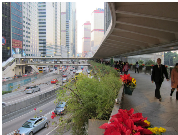
Photo 4 : Séparation des circulations pédestre et automobile
