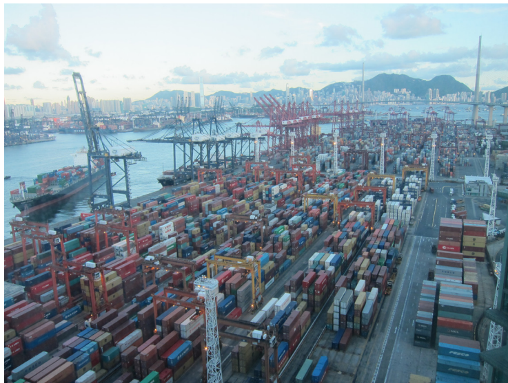
Photo 1 : Le terminal à conteneurs de Tsing Yi
